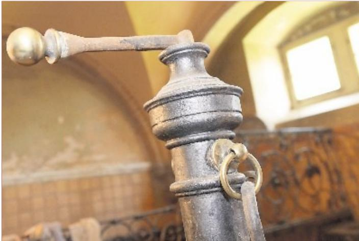
Durchdachtes Detail: Der oberste Knauf lässt sich herausklappen zum Aufhängen des Sattelzeugs.
