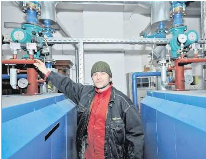
Gemeindearbeiter Falk Hoyer in der Heizungsanlage des Schlosses, die kostensparend umgebaut werden soll.
