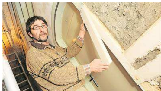
Diplom-Restaurator Andreas Schulz beim Anbringen von Stuckleisten im
