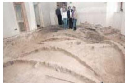
Einen ungewöhnlichen Anblick bietet zurzeit das Herrenzimmer im dicken Turm. Wegen Schwammbefall musste der gesamte Fußboden herausgenommen werden. Auch die Sandfüllung wurde entfernt, so dass jetzt die Gewölbedecke freiliegt. Man sieht sozusagen das Kellergewölbe von oben. Wann die Bauarbeiten weitergehen, ist eine Frage der Finanzierung. Foto: Brühl
